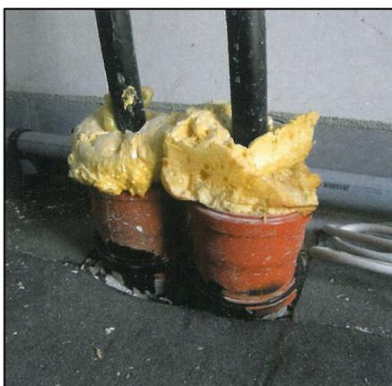
Nicht fachgerechte Hausanschlüsse durch die Bodenplatte bei Gebäuden ohne Keller.
