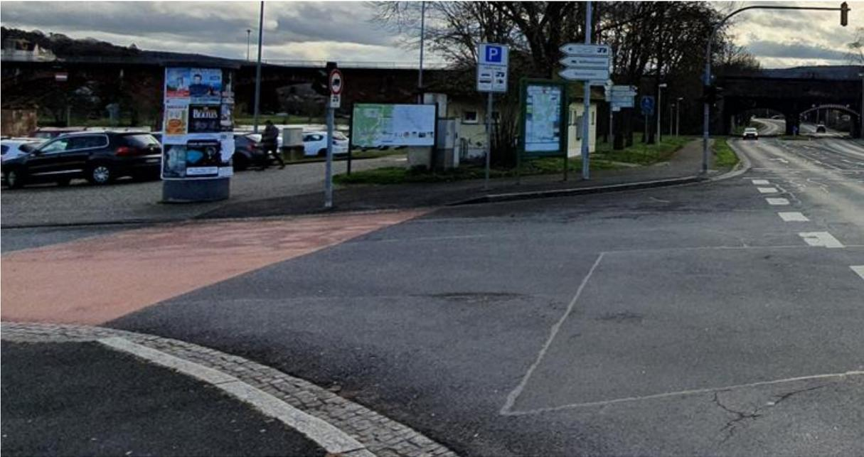
*Abbildung 14: Abgesetzte Querungen sollten nicht wie bevorrechtigte Furten markiert werden*
