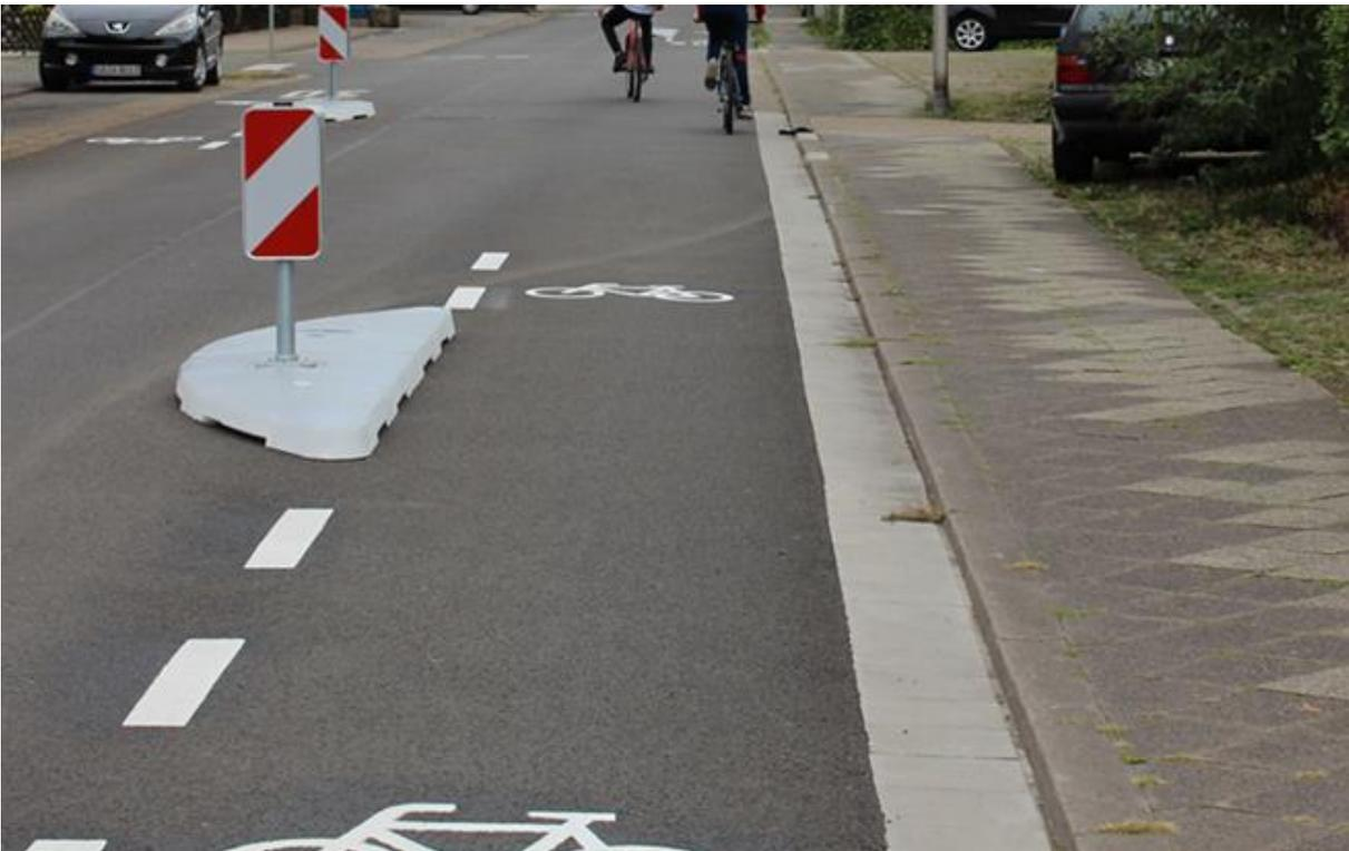
*Abbildung 74: Verkehrsinseln zur Verkehrsberuhigung mit Bypass für den Radverkehr*
